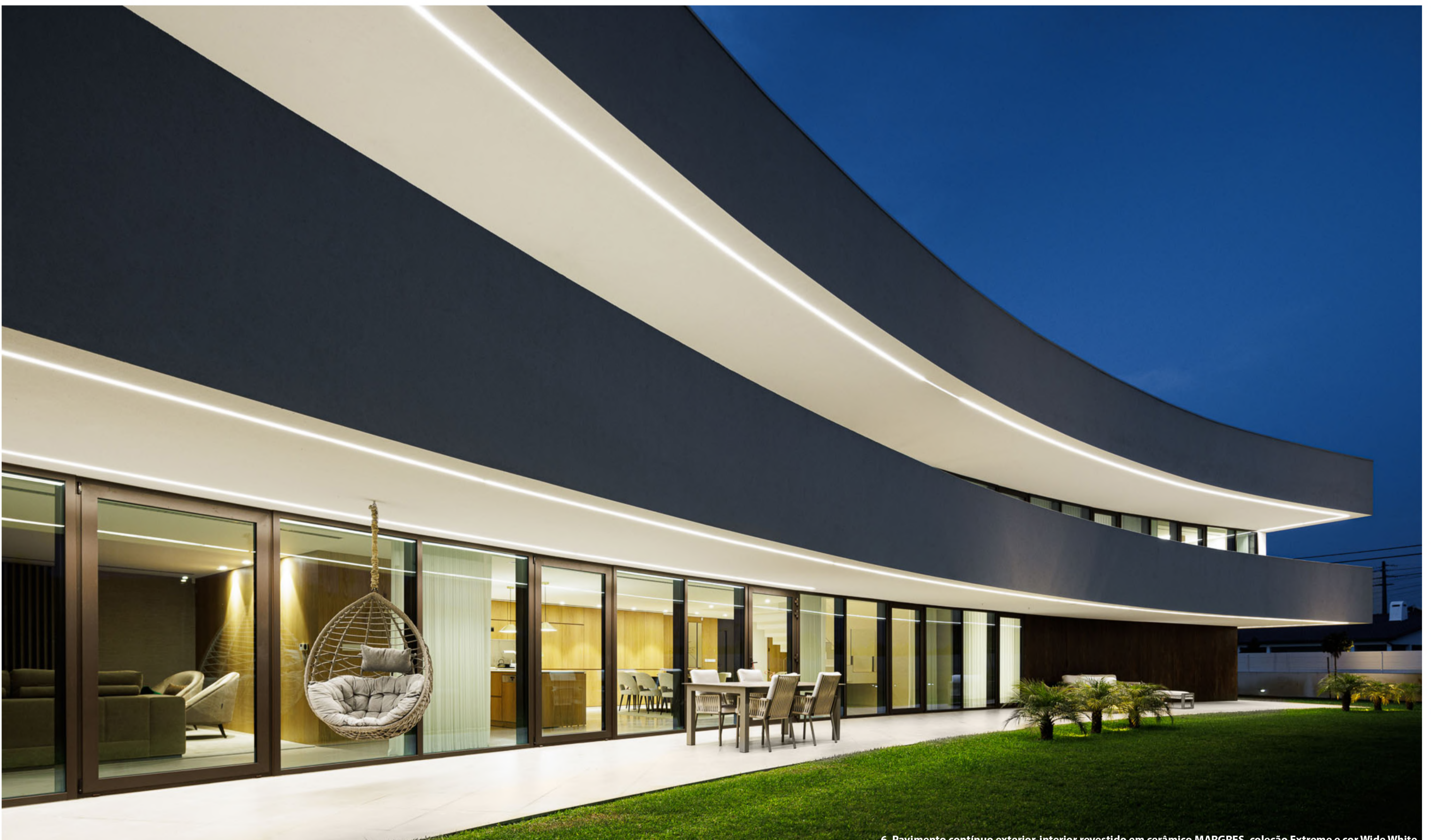
6. Pavimento contínuo exterior-interior revestido em cerâmica MARGRES, coleção Extreme e cor Wide White
