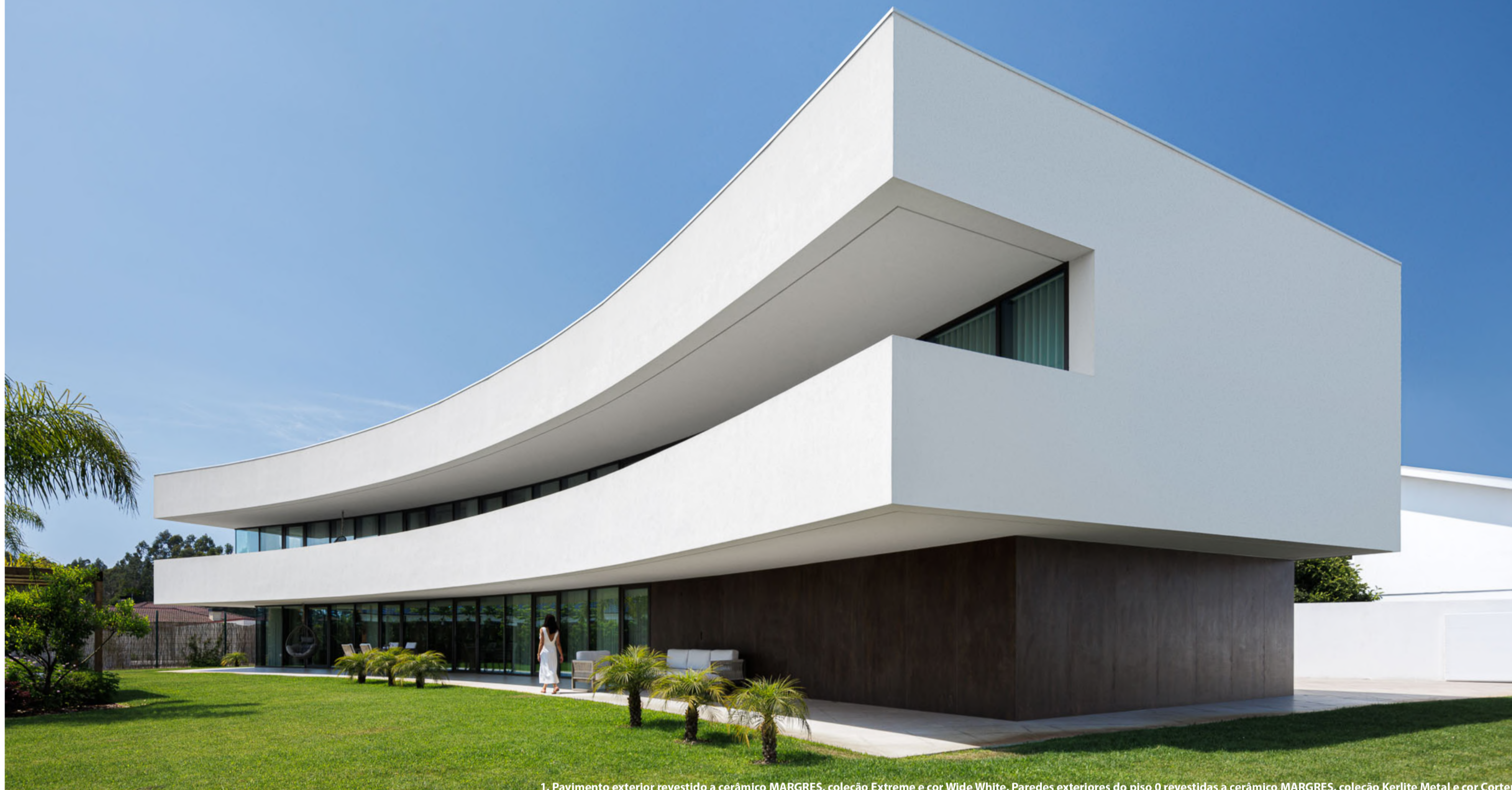
1. Pavimento exterior revestido a cerâmico MARGRES, coleção Extreme e cor Wide White. Paredes exteriores do piso 0 revestidas a cerâmico MARGRES, coleção Kerlite Metal e cor Corten
